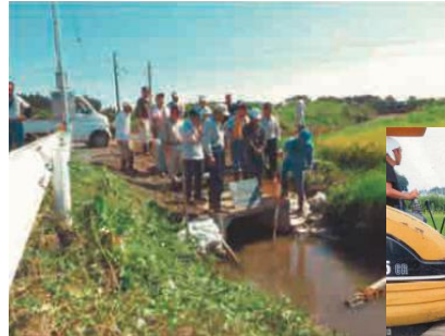
水路の補修風景
