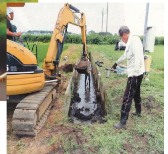
重機による水路の浚渫
