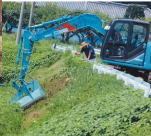
水路法面の草刈り作業
