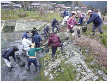
調整池の汚泥の除去作業
