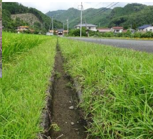
カバープラント施工後
