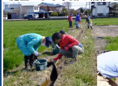
水路の補修風景
