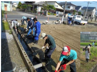
水路の清掃作業
