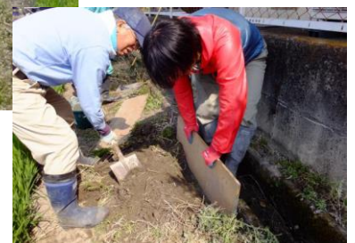
水路の補修風景
