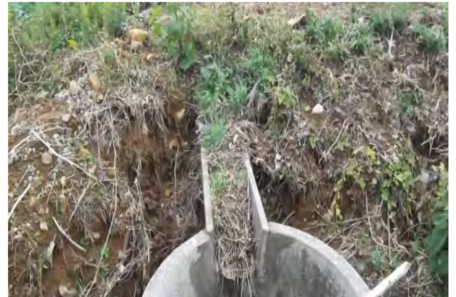
耕作放棄地となった農地の排水路。 土が排水路から流れて出している。
