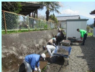
水路の草刈り・清掃風景
