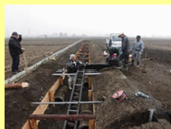
魚道の設置風景
