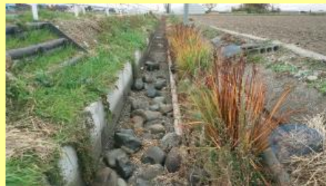
環境保全型水路
