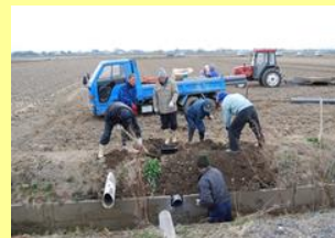
直営施工による落水マス設置風景
