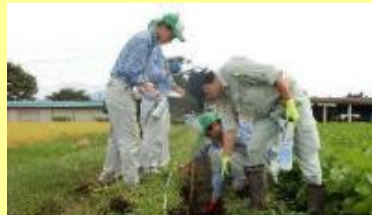
水路の点検診断
