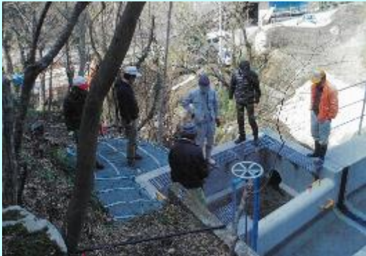
構成員による水路の点検
