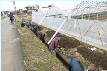
水路の泥上げ
