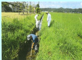
水路の泥上げ
