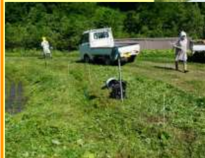
鳥獣害防止柵の設置作業
