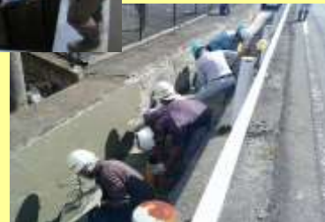
直営施工による水路の長寿命化
