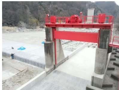
巻き上げ機更新と門扉の補修整備
