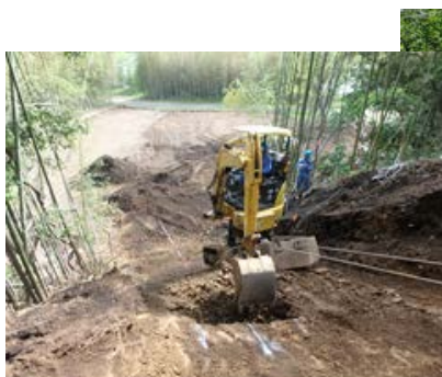
④ 工夫や安全確保が必要な斜面部の掘削・施工
