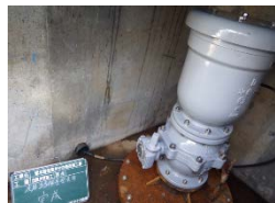
空気弁交換時の断水時間短縮に向けた事前ボルト交換と更新
