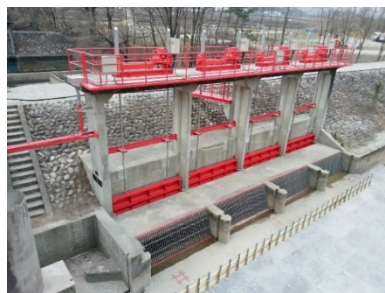
巻き上げ機とスクリーン更新と門扉の補修整備
