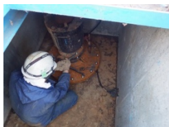
空気弁交換時の断水時間短縮に向けた事前ボルト交換と更新
