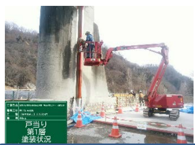
土砂吐水門設備工事用足場を自走式高所作業車に変更し土木工事との競合作業を解消
