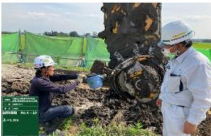
固化材使用量を低減できる地盤改良工法を採用(写真③)
