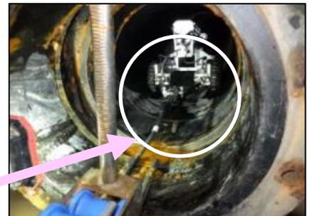
管内面調査+継手間隔計測状況
