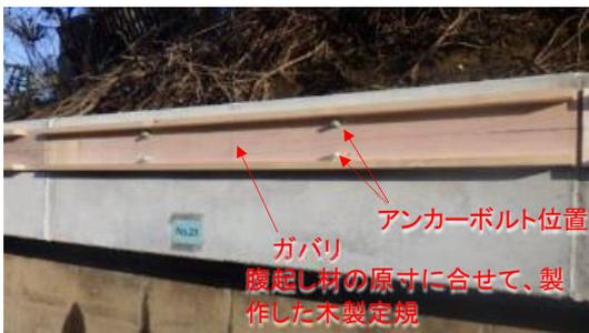
ガバリ(位置出し定規)によるアンカーの削孔位置出し
