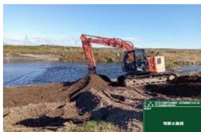
河川内堆積土を利用し大型土のうを作成 (写真③-2)
