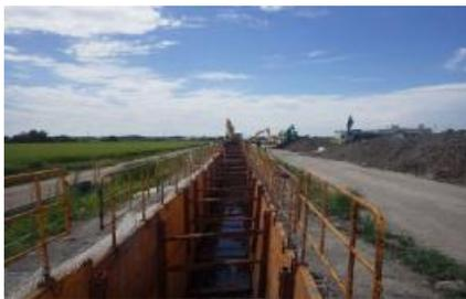
土留め材のパネルを高くし掘削内への雨水流入を防止(写真①)
