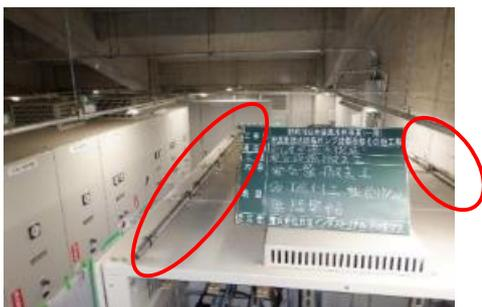
新機場へ仮置した盤の転倒防止(盤間緊結)
