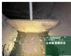
管内止水板設置
