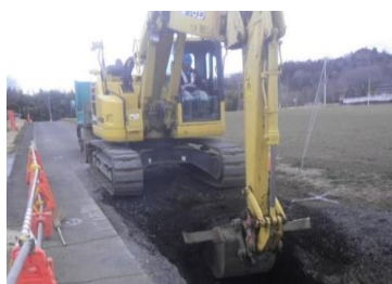
法面勾配バケットによる施工
