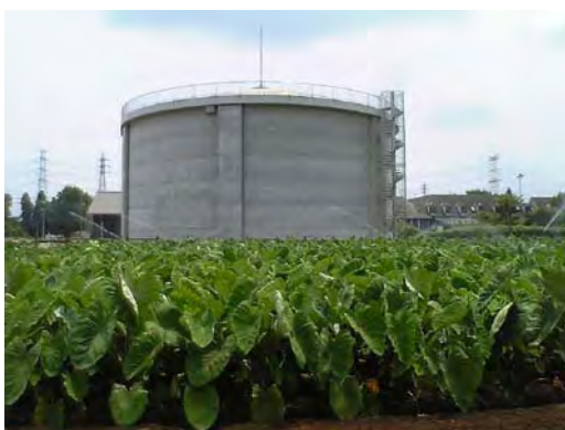
① 【12号調整水槽（八街市滝台）実証ほ場】
