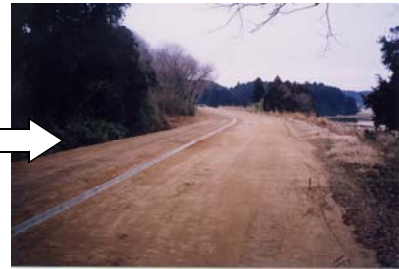
【パイプライン埋設完了】
