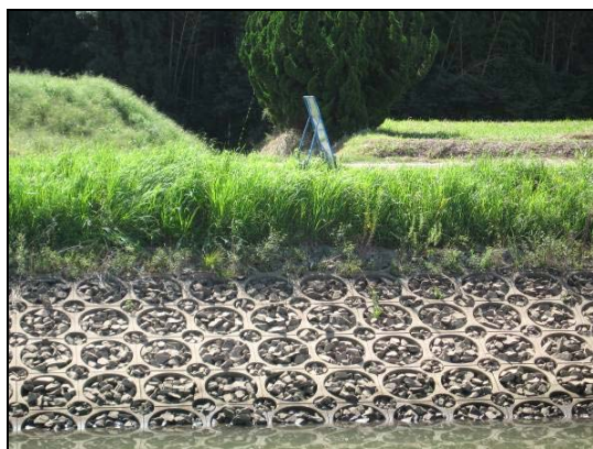
【大須賀川排水路】
