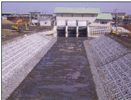
【八間川排水路】
