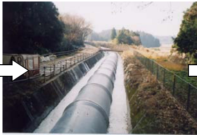
【パイプライン施工中】
