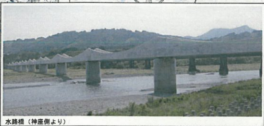
水路橋（神座側より）
