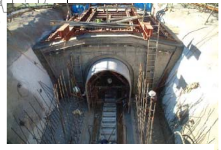
監査廊施工状況
