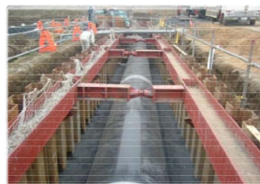
幹線用水路の埋設工事
