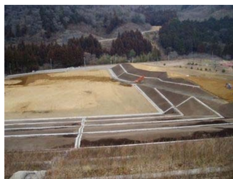
原石山への植生基盤材吹付
