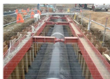
幹線用水路の埋設工事
