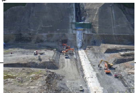
右岸より左岸を望む(監査廊天端)
