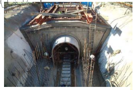
監査廊施工状況
