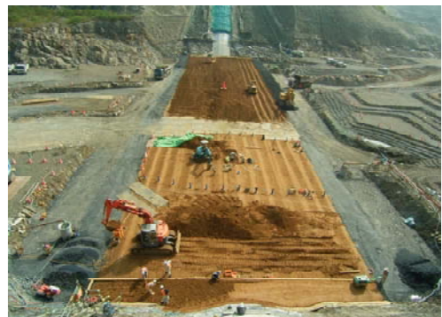
右岸より左岸を望む(堤体盛立状況)
