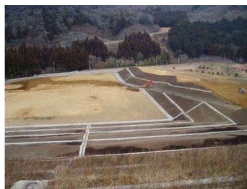
原石山への植生基盤材吹付
