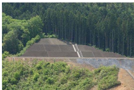
原石山への植生基盤材吹付
