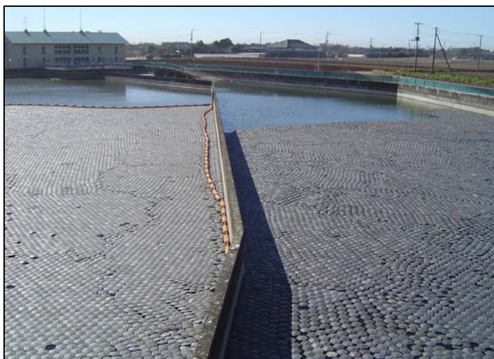
【富里揚水機場貯水槽の遮光フロート】
