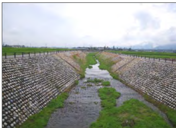
【あづみ野排水路】
