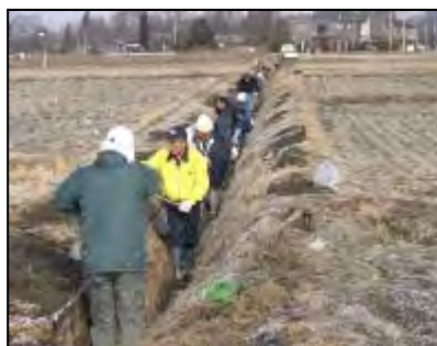
【水路の泥上げ】
