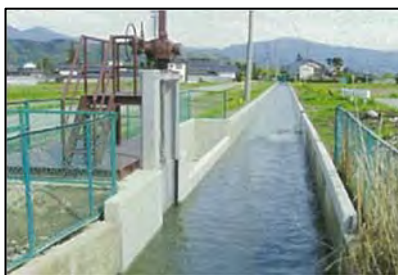
【勘左衛門堰排水路】
