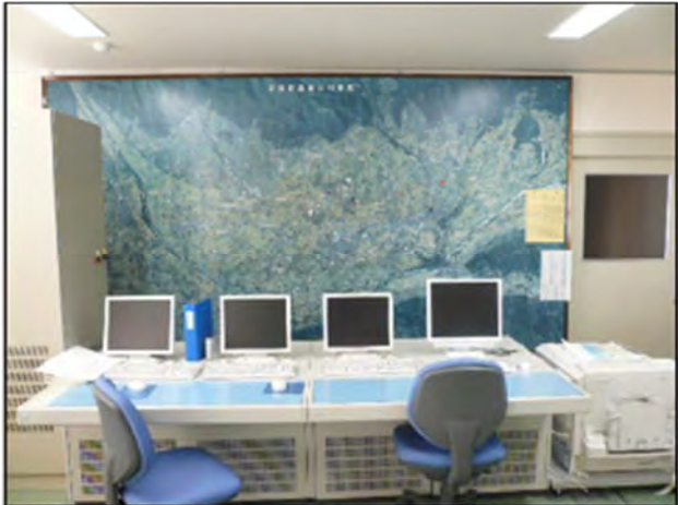
【排水管理システム】
