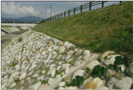
【自然石を使用した護岸】
