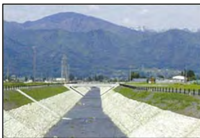
【あづみ野排水路】
