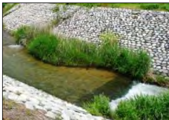
【水制工(水生生物の生育場の確保)】
