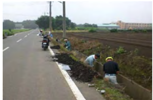
【農道側溝の泥上げ（岩井北部地区）】
