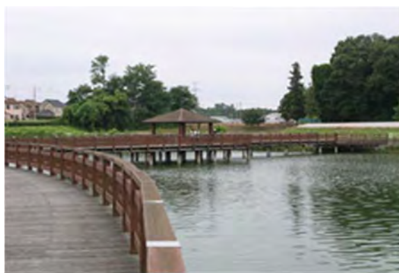
【東山田調整池に整備された親水デッキ】
