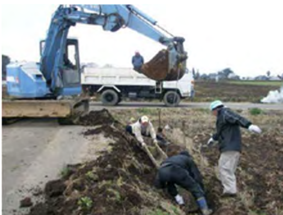
【水路の補修（百家地域）】
