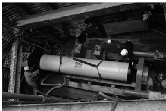
【水海道線の施工状況（推進工法）】
