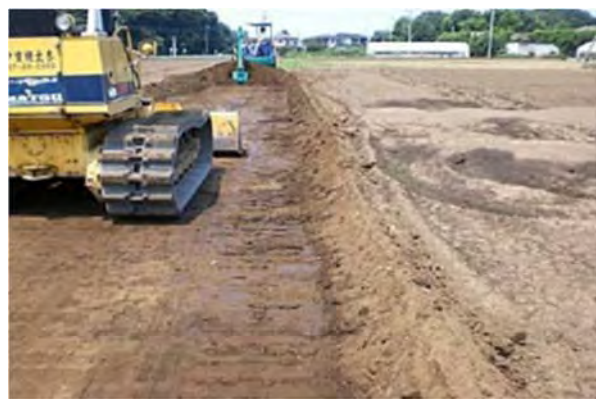
【農道の整備（岩井北部地区）】
