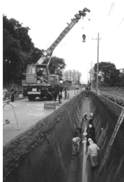
【猿島幹線の施工状況（管敷設）】
