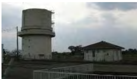
【新井揚水機場と吐水槽】
