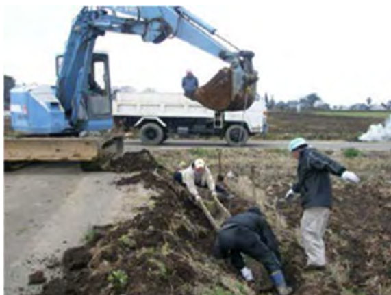
【水路の補修（百家地域）】
