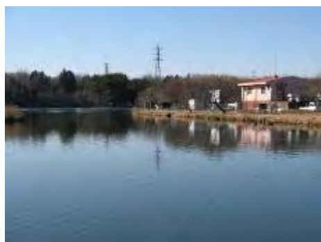
【上野沼調整池と上野沼揚水機場（一期事業）】
