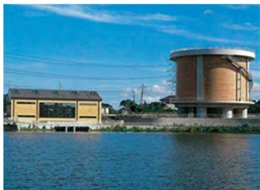
【東山田揚水機場と吐水槽】
