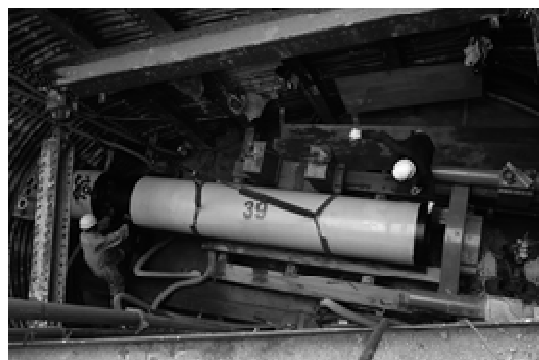
【水海道線の施工状況（推進工法）】
