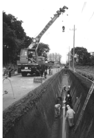
【猿島幹線の施工状況（管敷設）】
