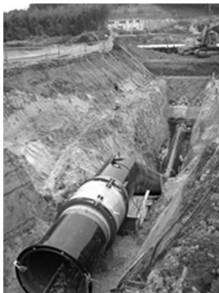
【笠間幹線の施工状況（涸沼川横断工）】
