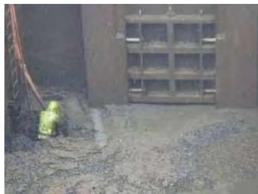
【吐出水槽の土砂やカワヒバリガイの撤去作業状況】
