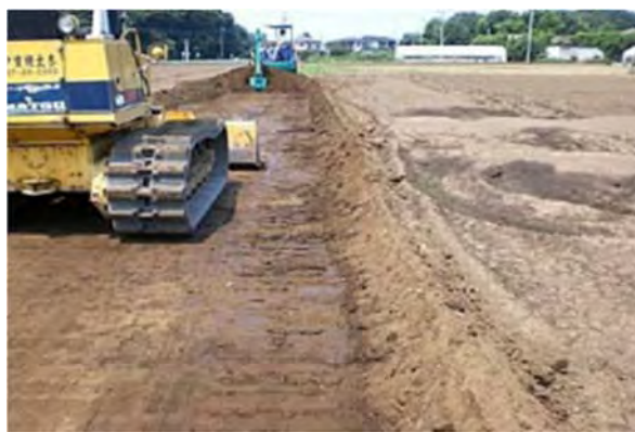
【農道の整備（岩井北部地区）】
