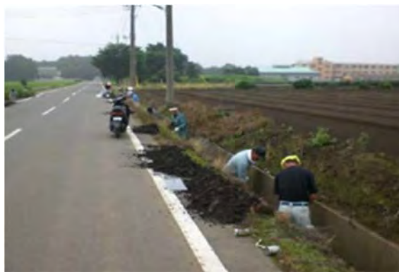
【農道側溝の泥上げ（岩井北部地区）】
