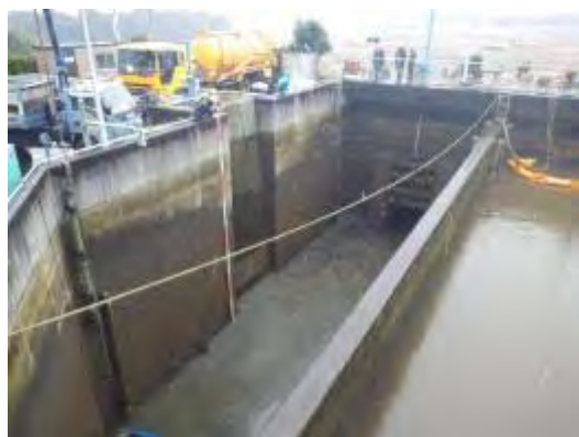
【吐出水槽の土砂やカワヒバリガイの撤去作業状況】
