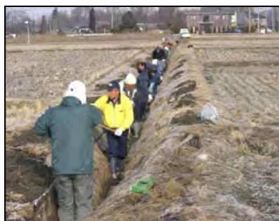
【水路の泥上げ】
