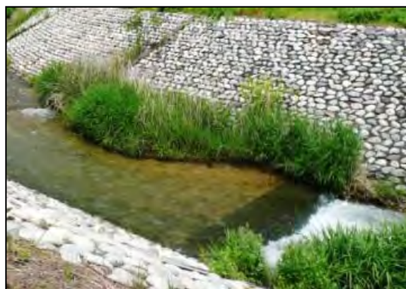
【水制工 (水生生物の生育場の確保)】
