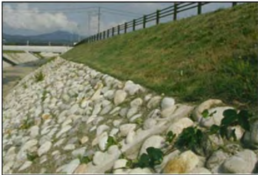
【自然石を使用した護岸】
