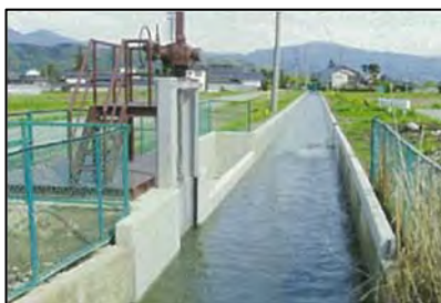
【勘左衛門堰排水路】
