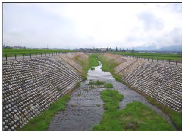
【あづみ野排水路】
