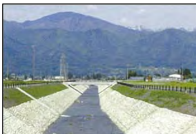
【あづみの野排水路】
