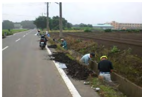
【農道側溝の泥上げ（岩井北部地区）】
