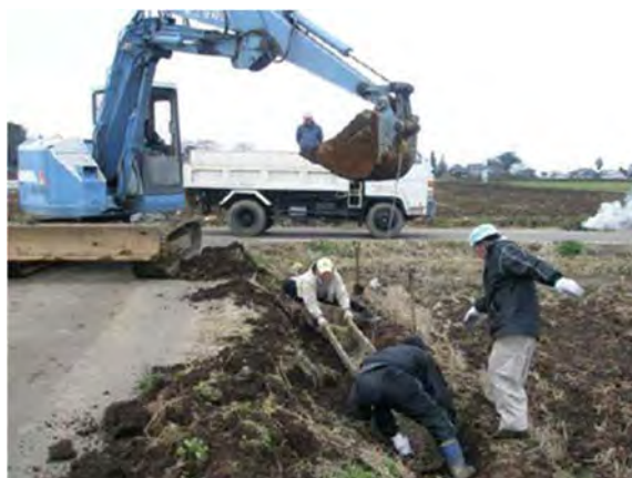
【水路の補修（百家地域）】
