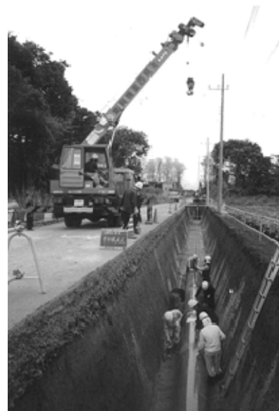
【猿島幹線の施工状況（管敷設）】
