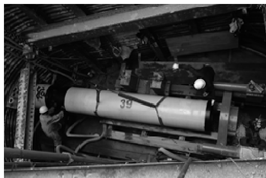
【水海道線の施工状況（推進工法）】
