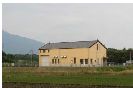
【明石揚水機場】
