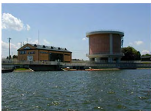
【景観との調和に配慮した揚水機场外観】
