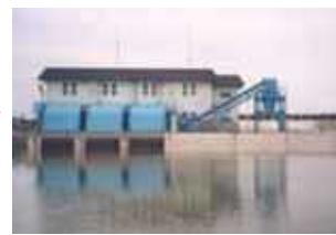
排水機場の整備
