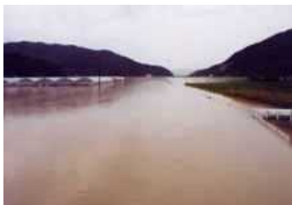
溢水した排水路
