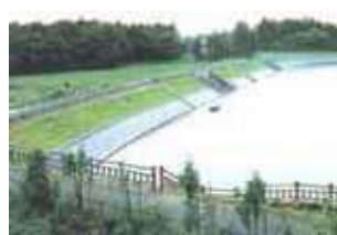
整備されたため池
