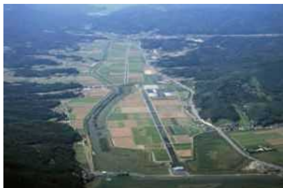
排水機場の整備による湛水被害の未然防止 熊本県天草市「小宮地地区」（湛水防除事業）
