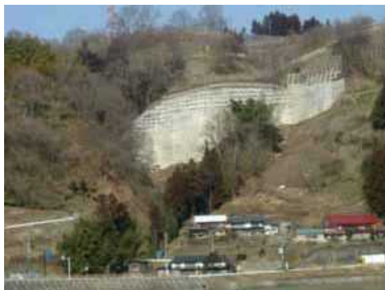
地すべり対策の実施による国土の保全 長野県信州新町「松葉地区」（地すべり対策事業）
