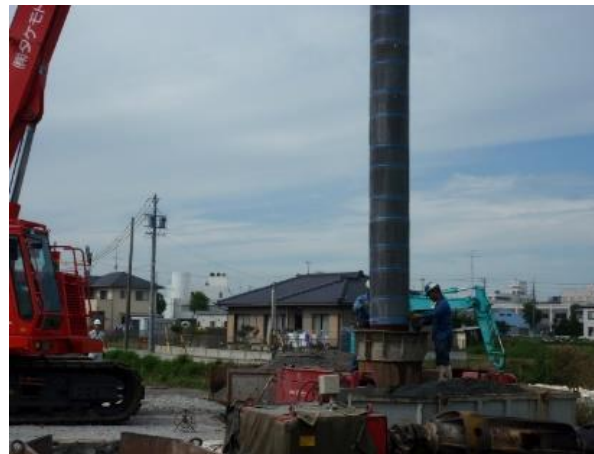
ディープウエルポイント施工状況
