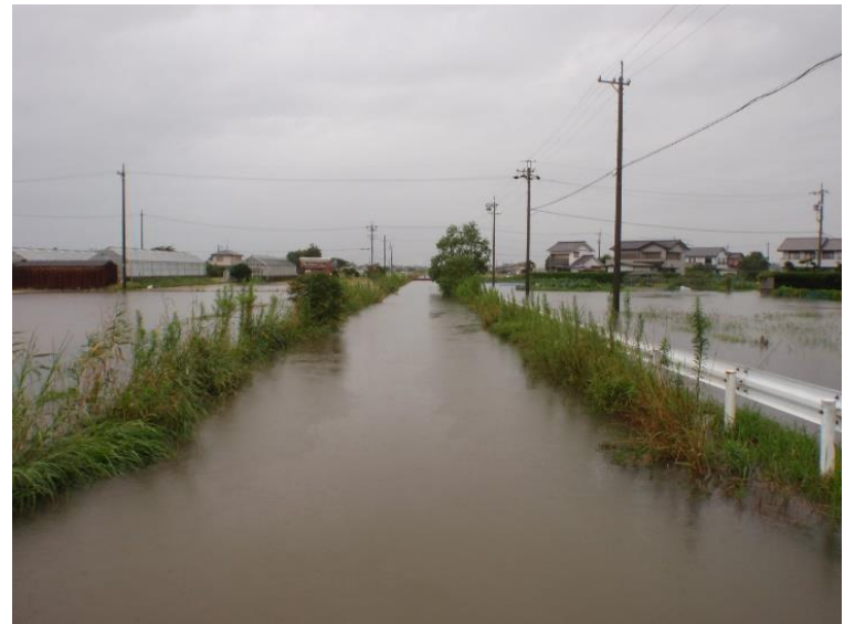
【湛水被害の状況】
