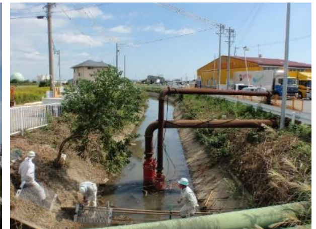
ディープウエルポイント施工状況
