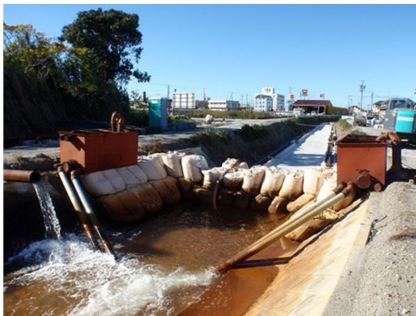
ウエルポイント排水状況
