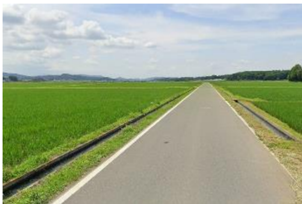
整備後の道路と用水路
