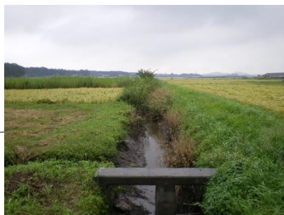
事業実施前の水路(用排兼用)
