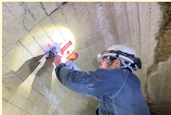
水抜き工 [ウィープホール設置]
