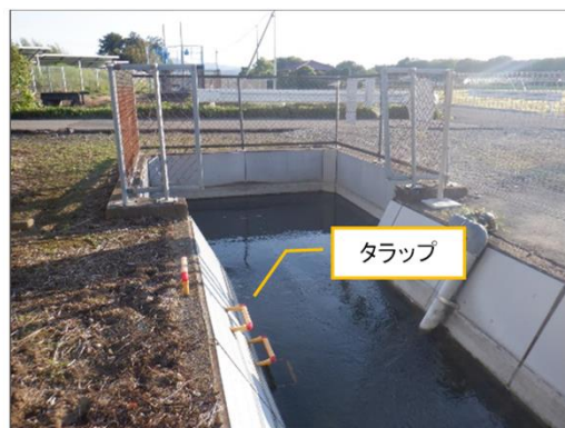
階段工(タラップ)の設置
