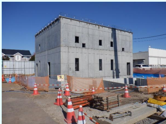
花園揚水機場(建設中)
