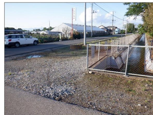
消防車両転回スペースの整備
