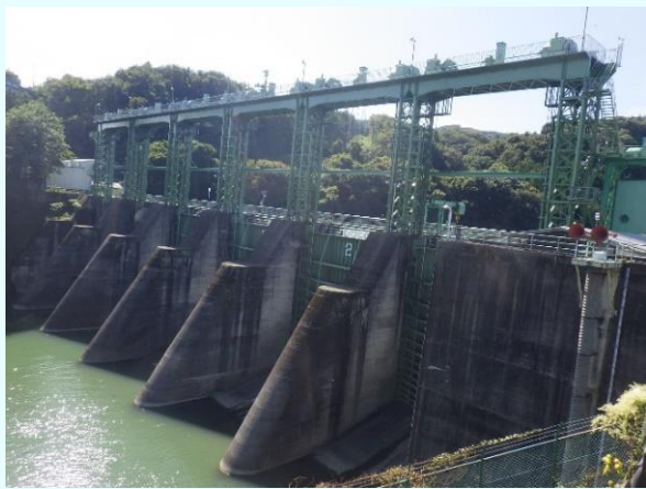
玉淀ダム(R4工事完了)
