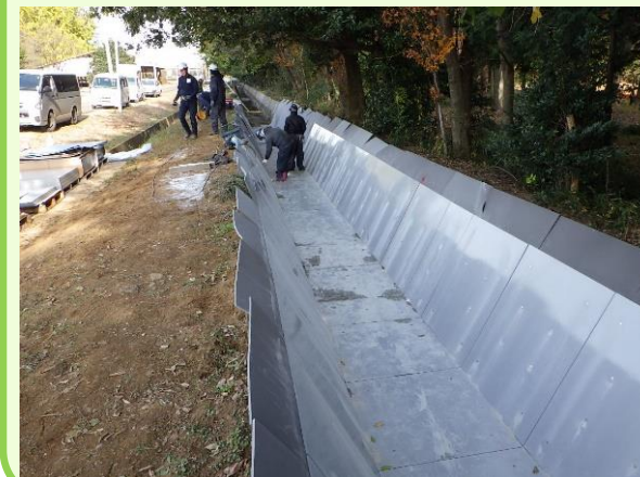
FRPパネル設置の様子(開水路)
