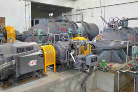
整備後(野田排水機場ポンプ設備)
