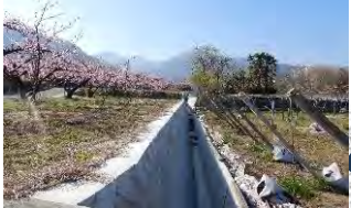
実施前(用排水路)
