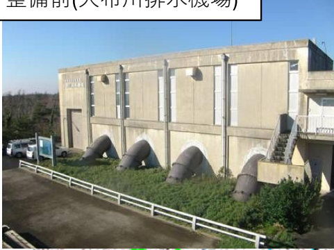
整備前(大布川排水機場)
