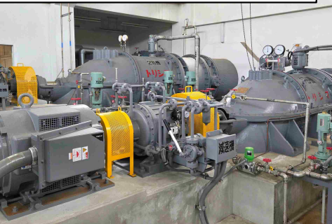
整備後(野田排水機場ポンプ設備)
