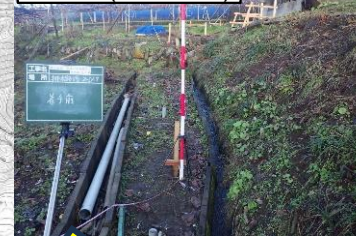
実施前(用排水路)
