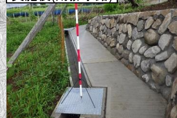
実施後(用排水路)
