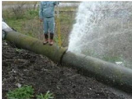
漏水が生じた管水路（露出配管）
