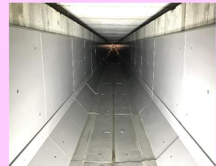
表面被覆(アンカー固定式パネル工法)による老朽化対策
