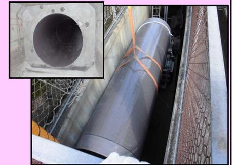
サイホン暗渠の管挿入(FRPM管挿入)による老朽化対策
