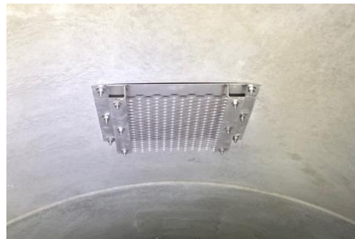
写真 トンネル天端に設置したコウモリピット
