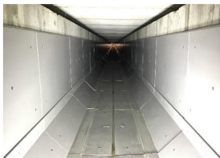
写真 表面被覆(アンカー固定式パネル工法)による老朽化対策
