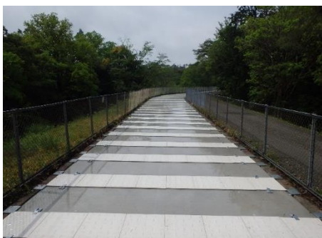
写真 蓋構造による耐震化対策
