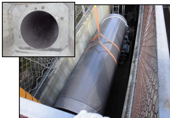
写真 サイホン暗渠の管挿入(FRPM管挿入)による老朽化対策
