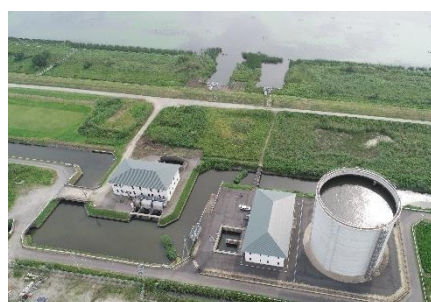
完成後の白山甚兵衛機場
