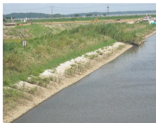
完成後の北調低地排水路
