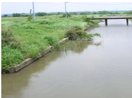
施工前の北調低地排水路
