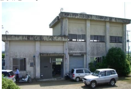
老朽化した白山甚兵衛機場
