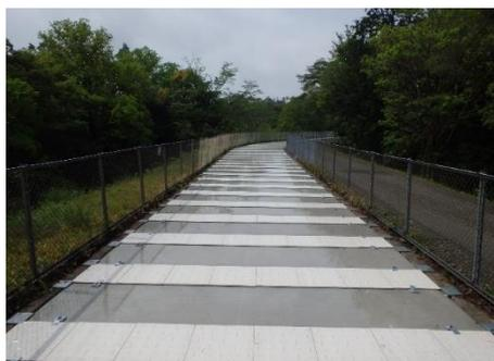
写真 蓋構造による耐震化対策
