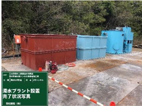
写真 濁水処理施設
