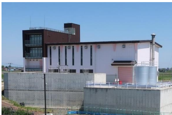
写真 与良川統合排水機場
