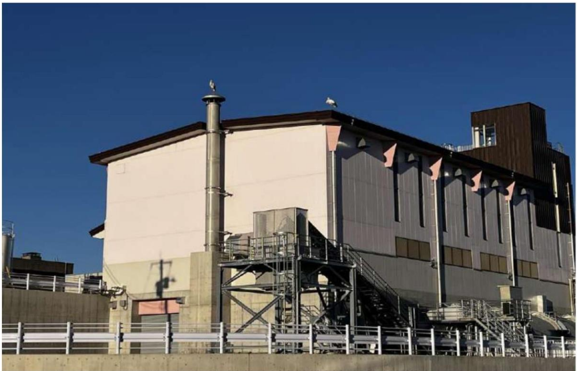
完成した与良川統合排水機場とコウノトリ
