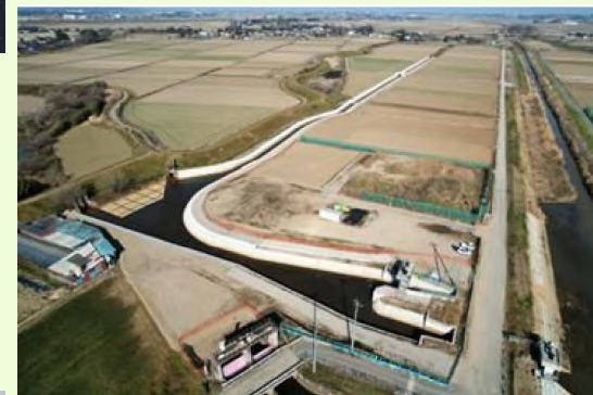
西部幹線排水路 (R7年度施工中)
