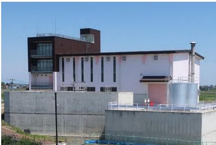
与良川統合排水機場
