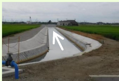
西清水川排水路 (R7年度施工中)
