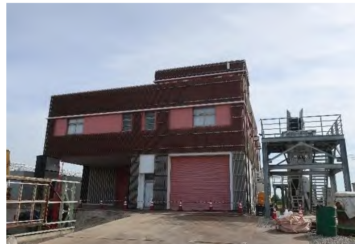
荒川排水機場
