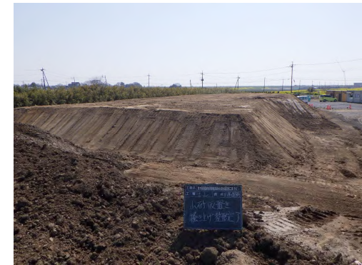
山砂の仮置き状況
