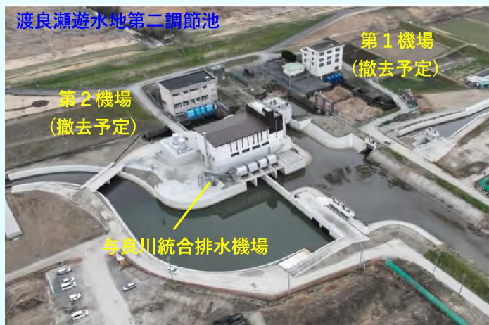
与良川統合排水機場 (R5年度完成)
