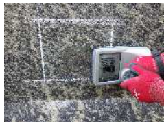
鉄筋探査・位置だし
