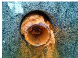
土砂堆積状況
