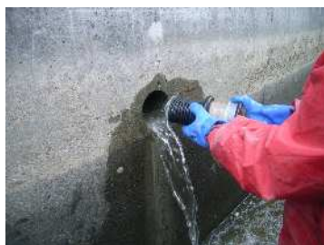
特殊な条件での施工事例 (流出水がある状況での施工)
