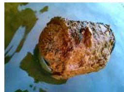
有孔管目詰まり状況
