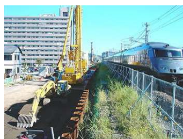
狭隘地での施工(営業線近接)
