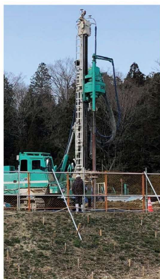
盛土法肩での施工実験
