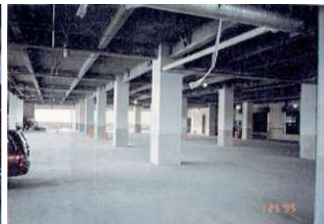
TOFT工法を適用したホテル内部
