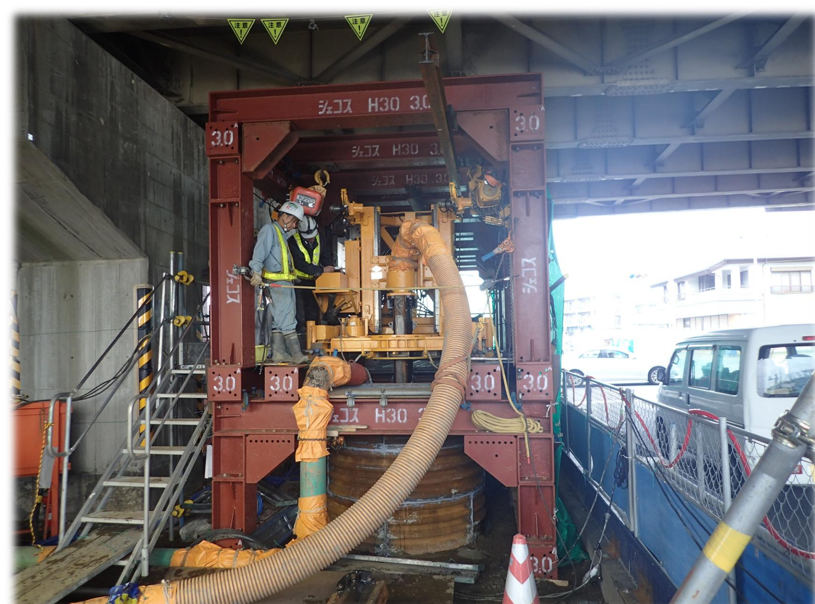
橋桁下（国道脇）
