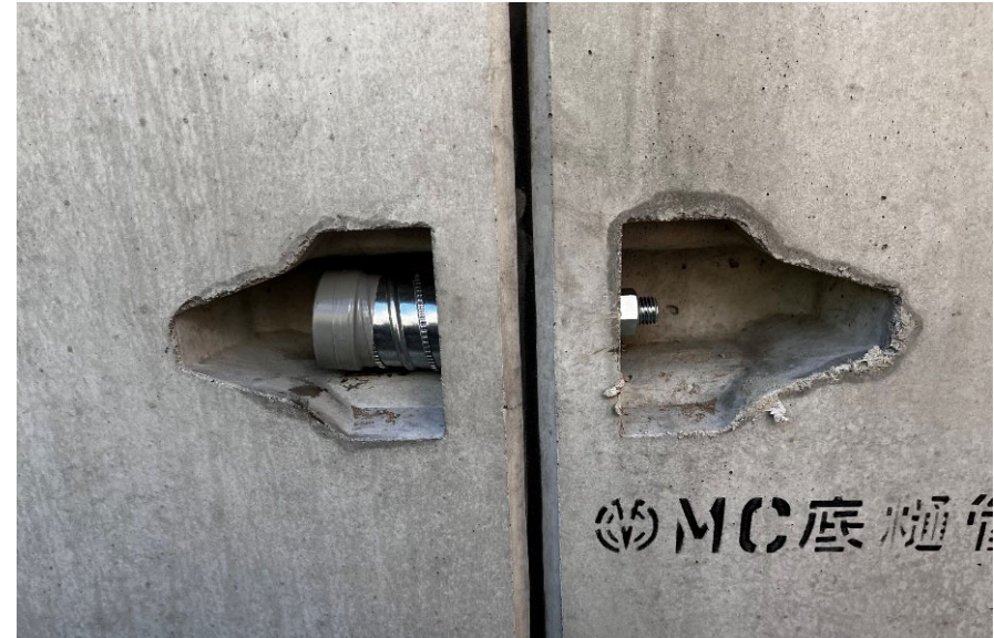
離脱防止ジョイント設置状況
