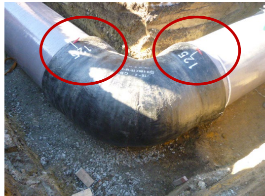
⑤施工完了
