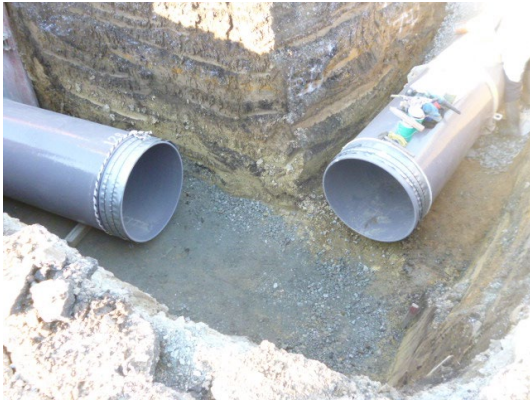
①曲管 据え付け前
