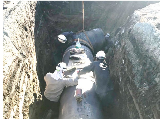
②曲管 接合状況
