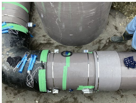
測定器設置状況
