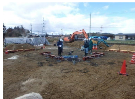
埋戻し後試験状況
