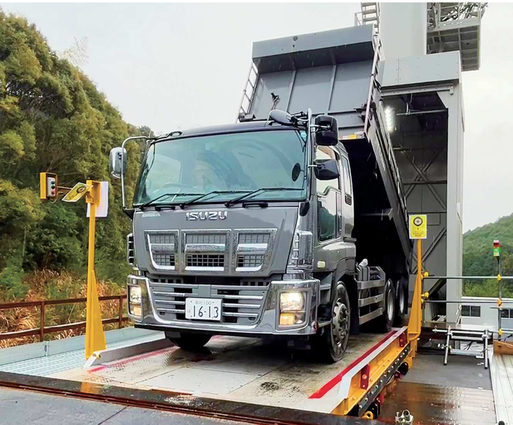
投入ホッパへの骨材の荷卸し状況
