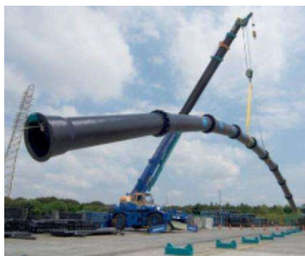
東京都水道局の依頼により吊上げ NS形（耐震継手） 呼び径500
