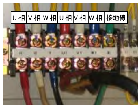
制御盤とキャブタイヤケーブル接続状況
